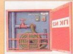
Для приведения в действие имеющихся в зданиях пожарных кранов откройте дверцу шкафчика, раскатайте в направлении очага пожара рукав, соединенный с краном и стволом. Откройте вентиль поворотом маховичка против хода часовой стрелки и направьте струю воды из ствола в очаг горения.
